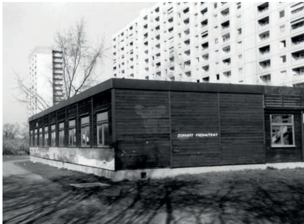
Schulpavillon, später „de club“, hinter Königsbruch 1-5
